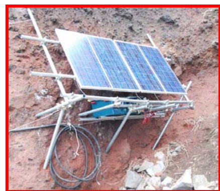
録画機、蓄電池と太陽電池
